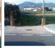
PUNT 24: N-II Pk. 636, 600 6 TANQUES
