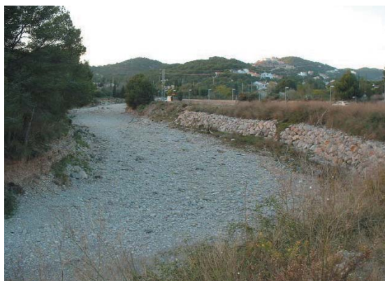
Figura 4. Canal fluvial d'una riera litoral en la qual s'ha endegat i reduït la seva secció.
